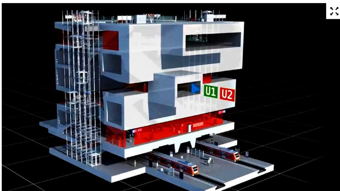
So sollte es aussehen: Die Pläne für den neuen Hauptbahnhof sahen vor, dass der Bahnsteig der zweiten Stammstrecke in gut 40 Metern Tiefe unter dem für die U1 und die U2 liegt. Doch nun muss die Haltestelle deutlich verschoben werden – auf diesem Bild links hinter das Bauwerk. © Visualisierung: Bahn
