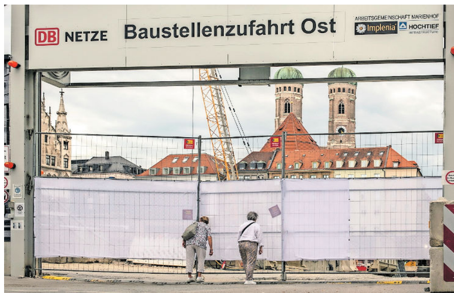
Was geht vor hinter den Kulissen der Baustelle zweite S-Bahn-Stammstrecke? Das Projekt wird immer mehr zu einem Loch ohne Boden. FOTO: IMAGO
