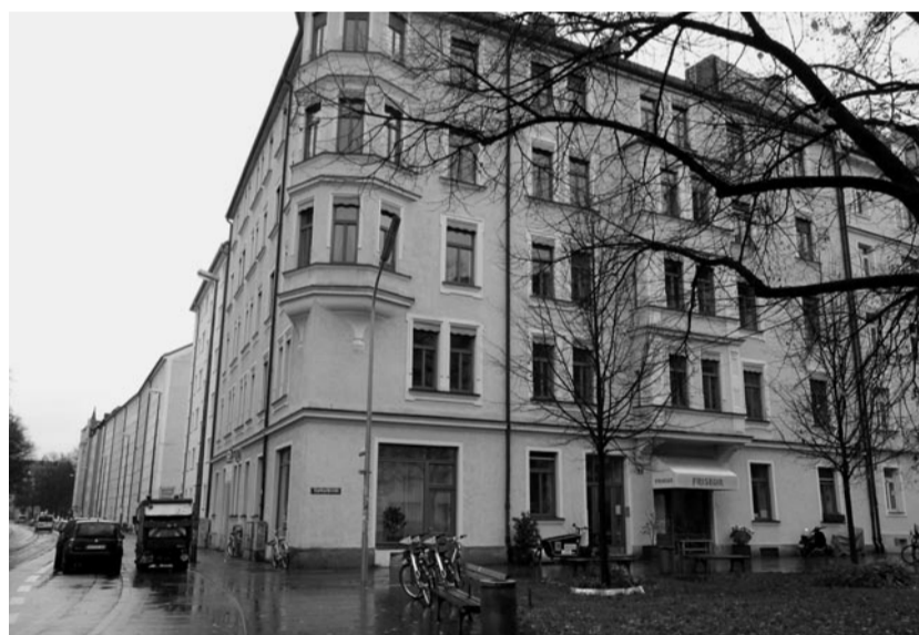
Aurbacherstraße 1 – kein Platz für eine Regenwasserzisterne?
