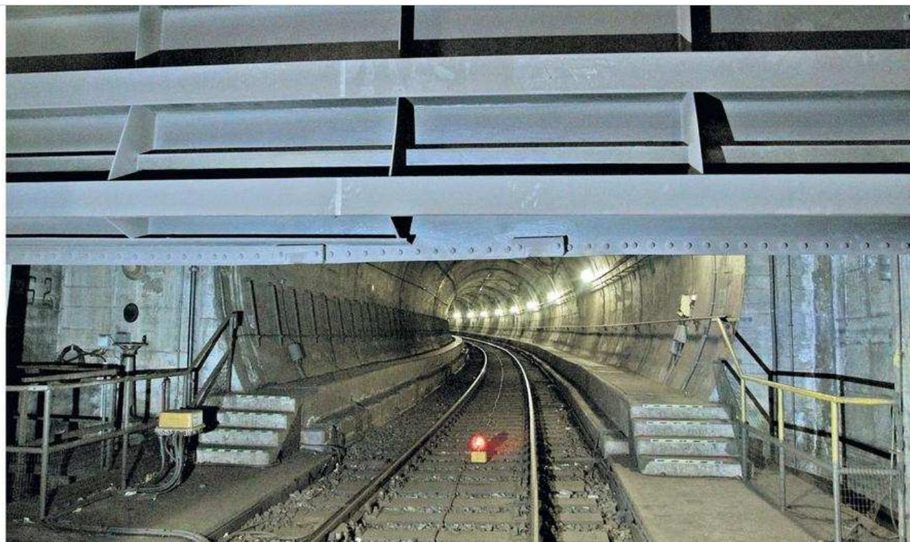
Falls die Isar je die Decke des Stammstrecken-Tunnels durchbricht, sollen zwei je 25 Tonnen schwere Wasserschutzore die S- und U-Bahn schützen.
